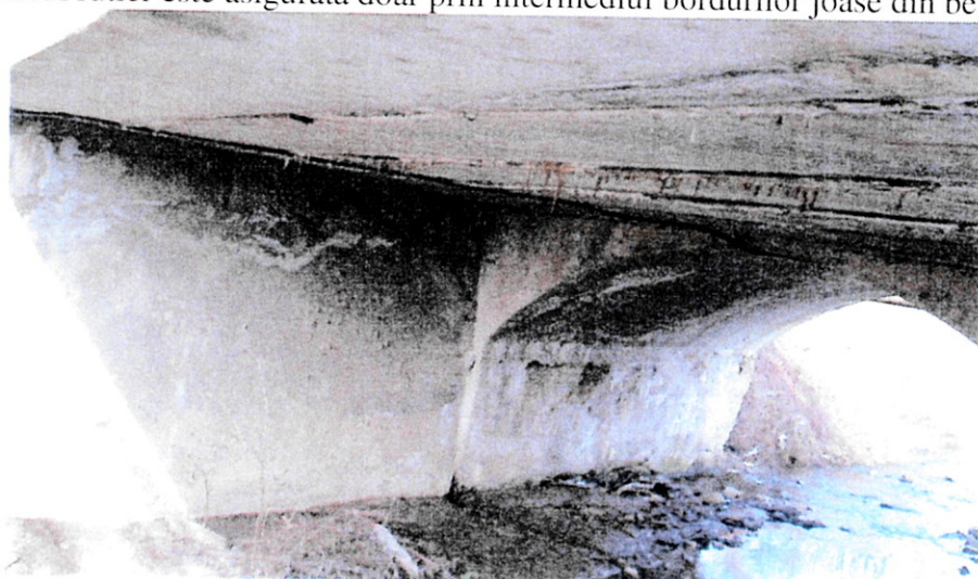
Pod peste pâraul Moșna, str. Moșnei intersecție cu Avram Iancu
